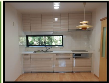
リフォーム工事
